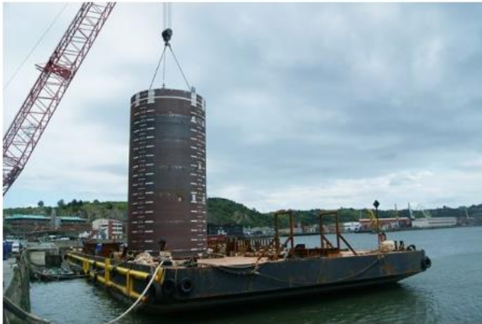
Carga de un ancla para eólicos en las instalaciones de Navacel
