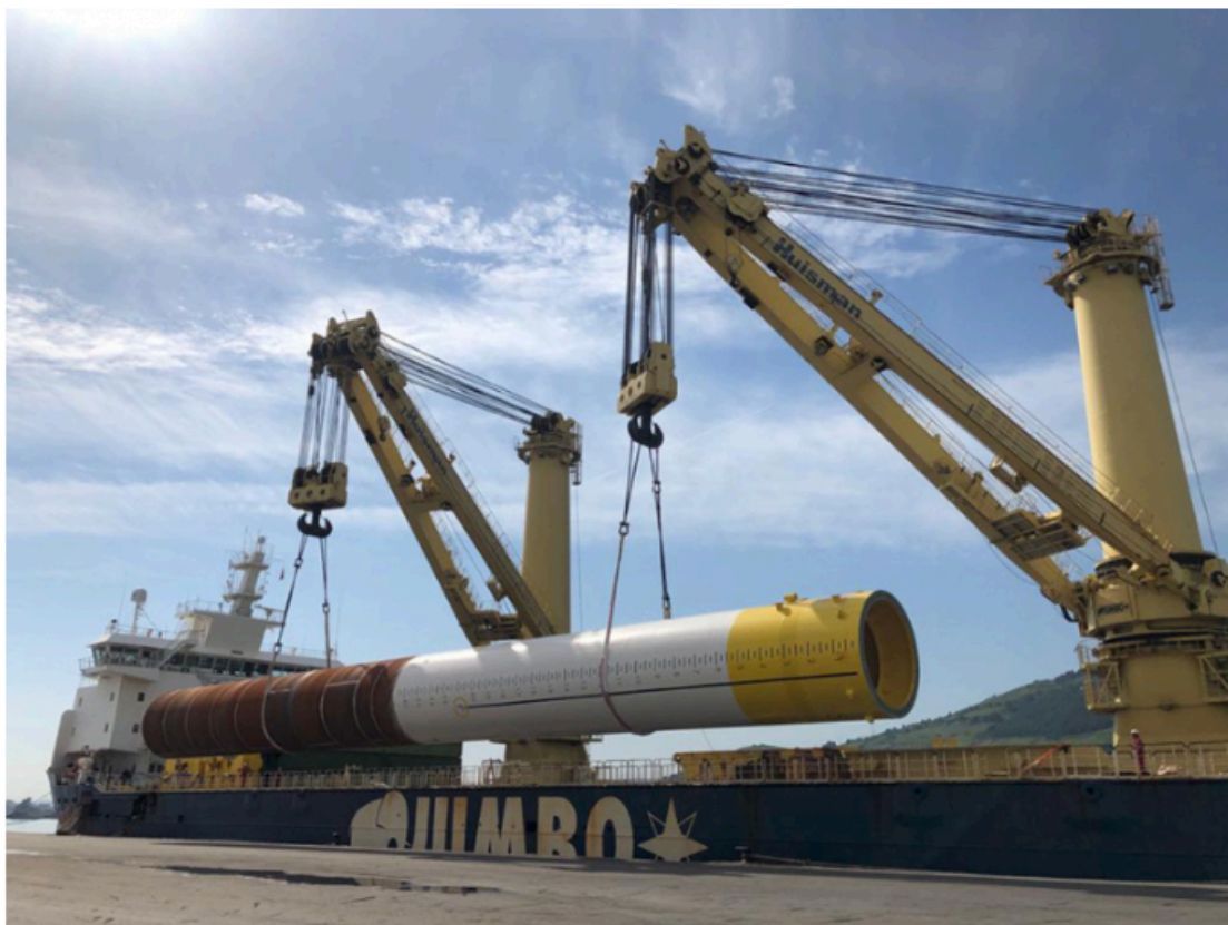
SLP participa en el primer embarque de monopiles para eólica offshore realizado en el Puerto de Bilbao.
