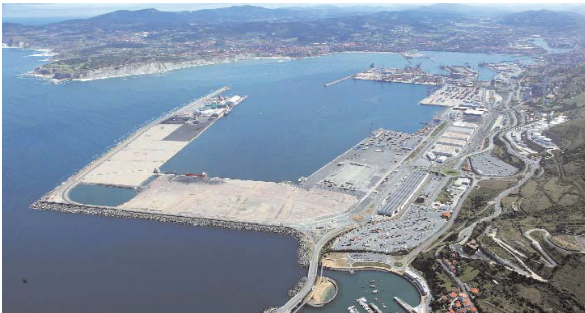
El AZ-2 ha sido el séptimo muelle que ha construido la Autoridad Portuaria desde el inicio de las obras de ampliación en el Abra exterior en 1992.
