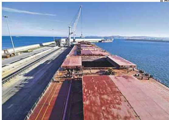
Las instalaciones de SLP disponen de una línea de atraque de 1,7 kilómetros de longitud con calados de hasta 20 metros.
