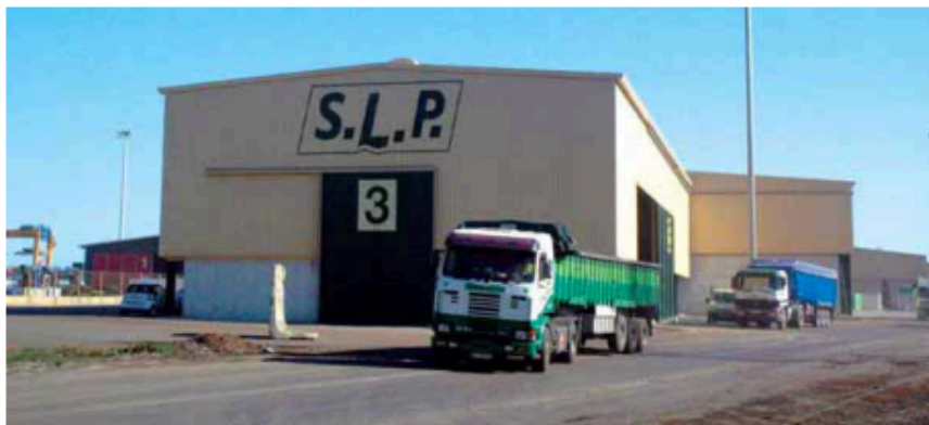
La nave de SLP destaca, además de por las vigas exteriores y ventilación natural, por su distribución interior para acoger distintos tipos de graneles sólidos. Foto J.P.
